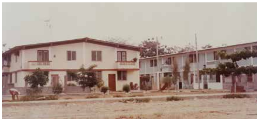
Figura 6. Bloques 4 y 5 de villas de Ciudadela Sopeña, entregadas en enero de 1980
