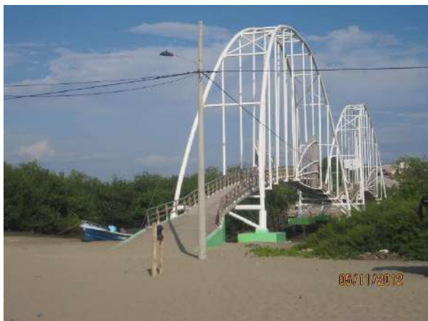
Vista del puente peatonal de Bellavista que cruza un estero para acceder al carretero que va hasta Campoalegre .
